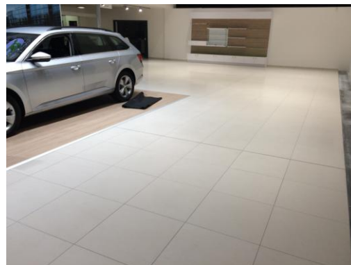
dlažba po vyčištění
