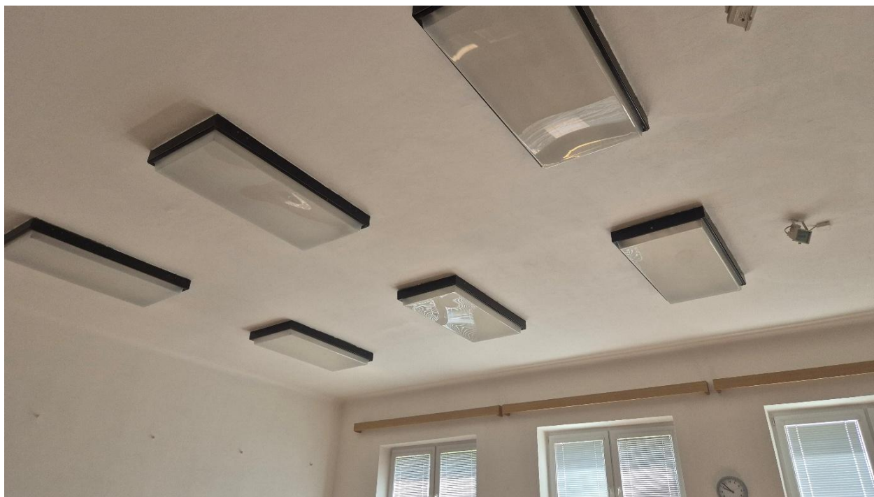
Světla před rekonstrukcí
